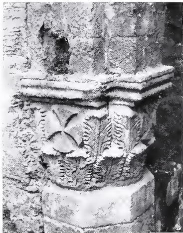
Fig. 14. - MESSINA - Chiesa di S. Maria alla Scala. Uno dei quattro capitelli del sistema centrale della nave trasversa.
